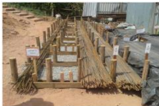
Foto 1 e 2 – Armazenamento de barras de aço.
