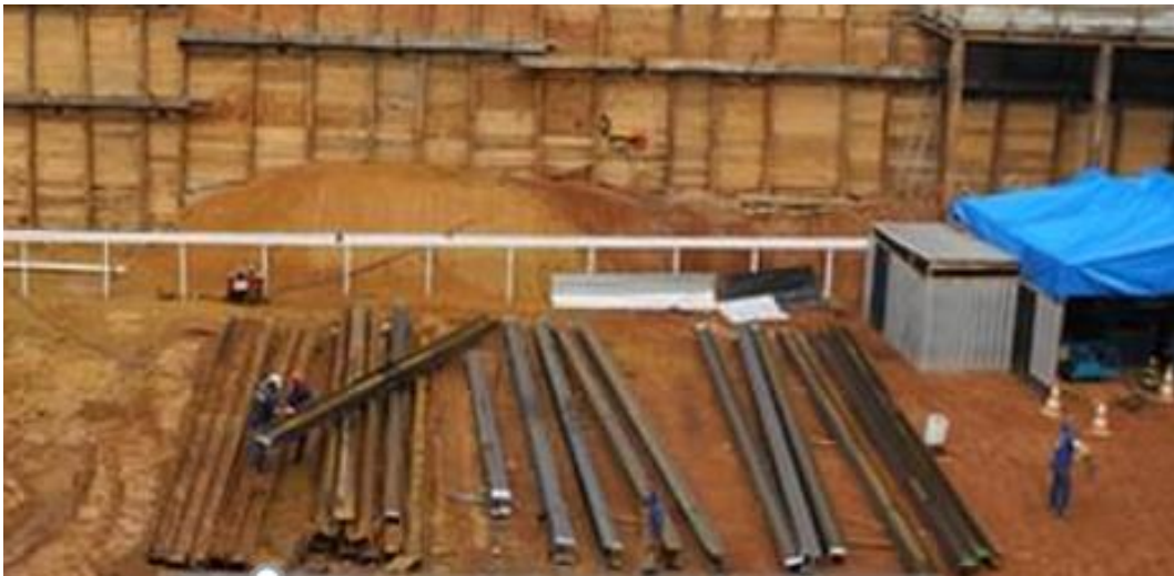
Foto 3 – Armazenamento de perfis de aço.
