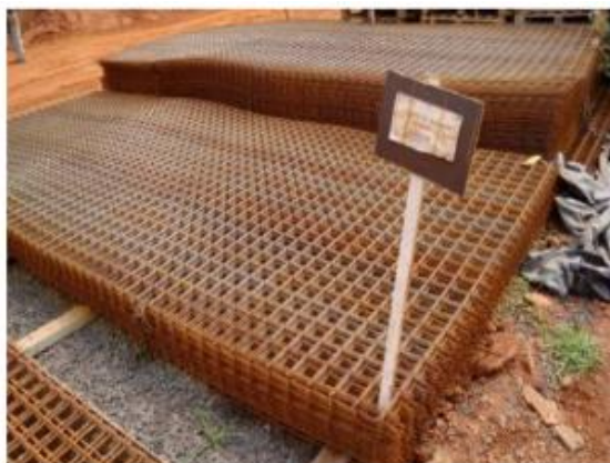
Foto 3 – Armazenamento de telas de aço.
