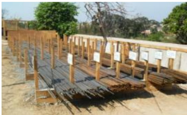
Foto 1 e 2 – Armazenamento de barras de aço.
