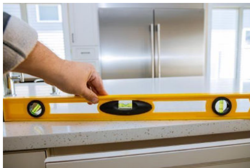
Foto 1: Verificação do nivelamento e planicidade das peças
