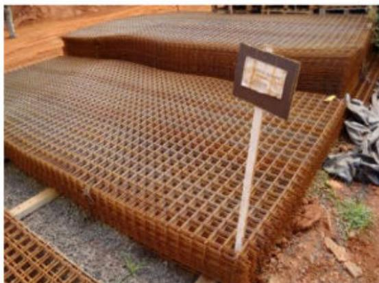
Foto 3 – Armazenamento de telas de aço.
