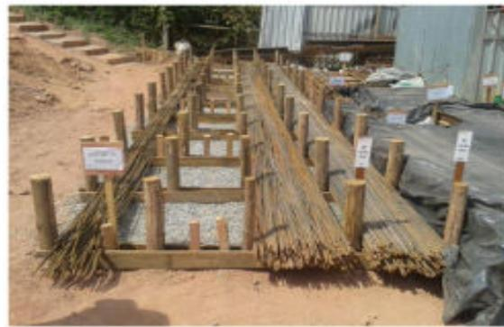
Foto 1 e 2 – Armazenamento de barras de aço.
